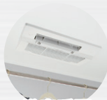
浴室暖房 乾燥機
