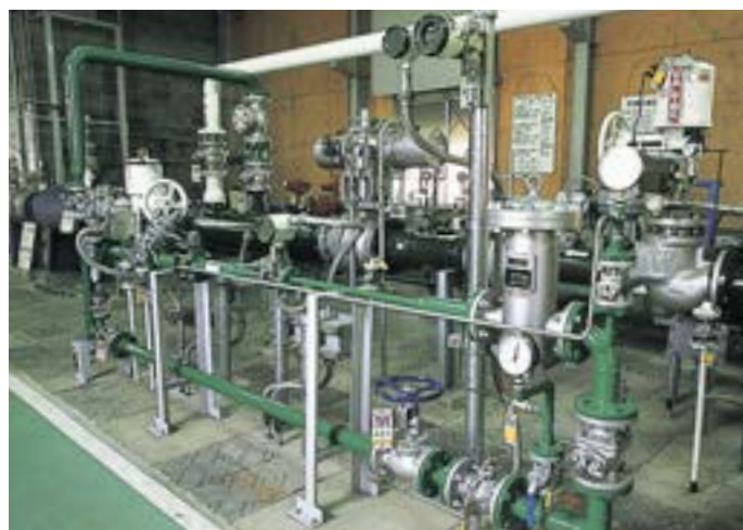
消化ガス受入設備(蔵王工場)
