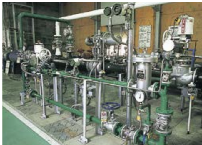
消化ガス受入設備(蔵王工場)
