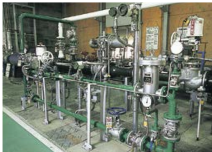
消化ガス受入設備(蔵王工場)
