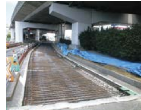
温水配管施工中 道路下に直径15mmの温水配管を延べ4.3km敷設し、678m 2 の路面を融雪しています。
