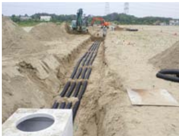
埋設電線管敷設工事
