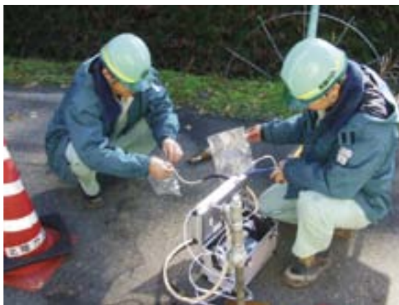
本支管末端地点で13 A ガスへの置換確認作業を行いました。
