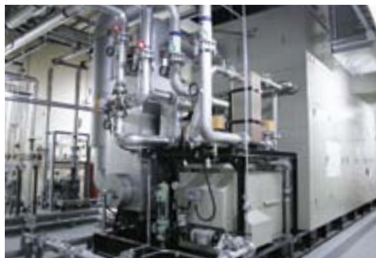
ガスエンジンコージェネレーション
