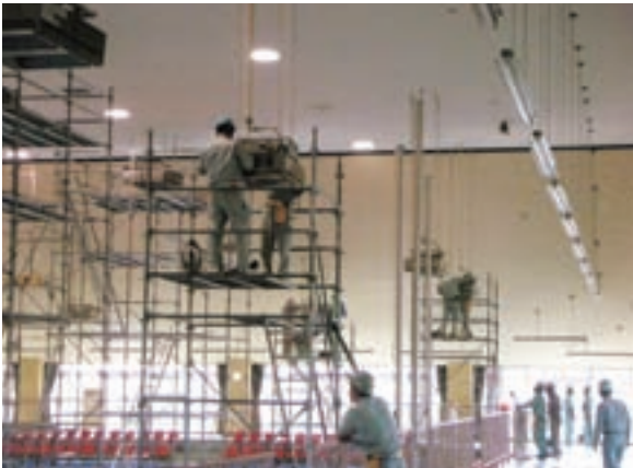
体育館の吊り下げストーブの調整作業は、足場を設営し高所での作業となりました。
