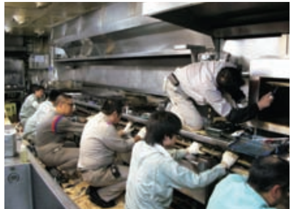
業務用厨房内でのガスレンジ（9台連結式）調整作業は、9名が横に並んで一斉にノズルの交換等を行いました。
