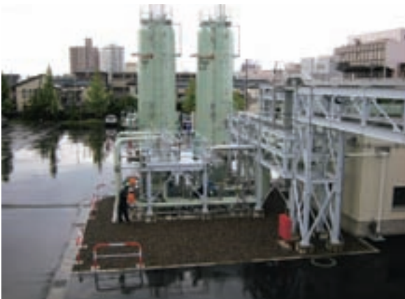
8月の東港工場、9月の山の下工場に続き、10月には関屋工場において新設した増熱設備を実際に稼働し、13Aガスを製造する総合試運転を実施いたしました。
