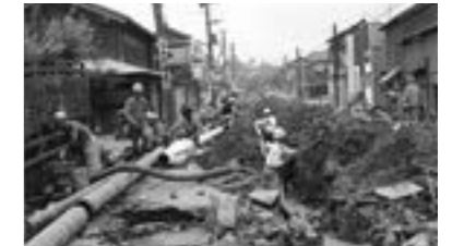
新潟地震 懸命の復旧作業(1964)
