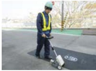
ガス導管の漏えい検査
