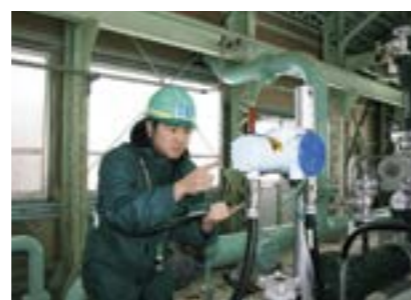
工場の巡視点検
