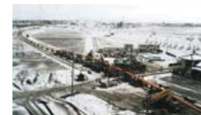
東港幹線工事(2000~2004) 「阿賀野川河川下横断時の様子」
