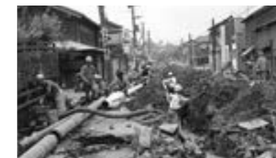
新潟地震 懸命の復旧作業(1964)
