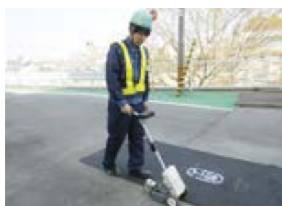
ガス導管の漏えい検査
