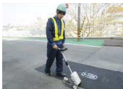
ガス導管の漏えい検査
