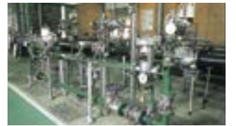
消化ガス受入設備(蔵王供給所)
