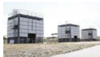
天然ガス生産井
