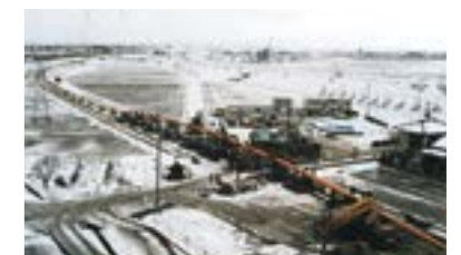
東港幹線工事(2000~2004) 「阿賀野川河川下横断時の様子」
