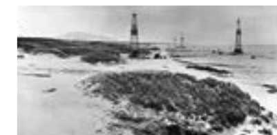
海岸線に沿ってやぐらが続く新潟ガス田(1949)
