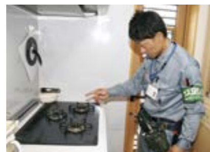
ガス設備検査
