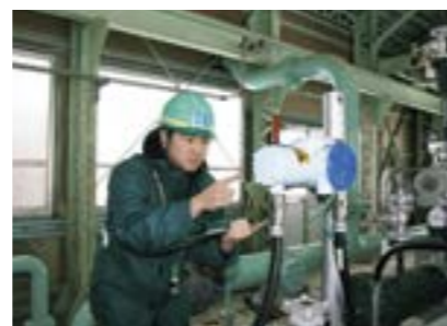
工場の巡視点検
