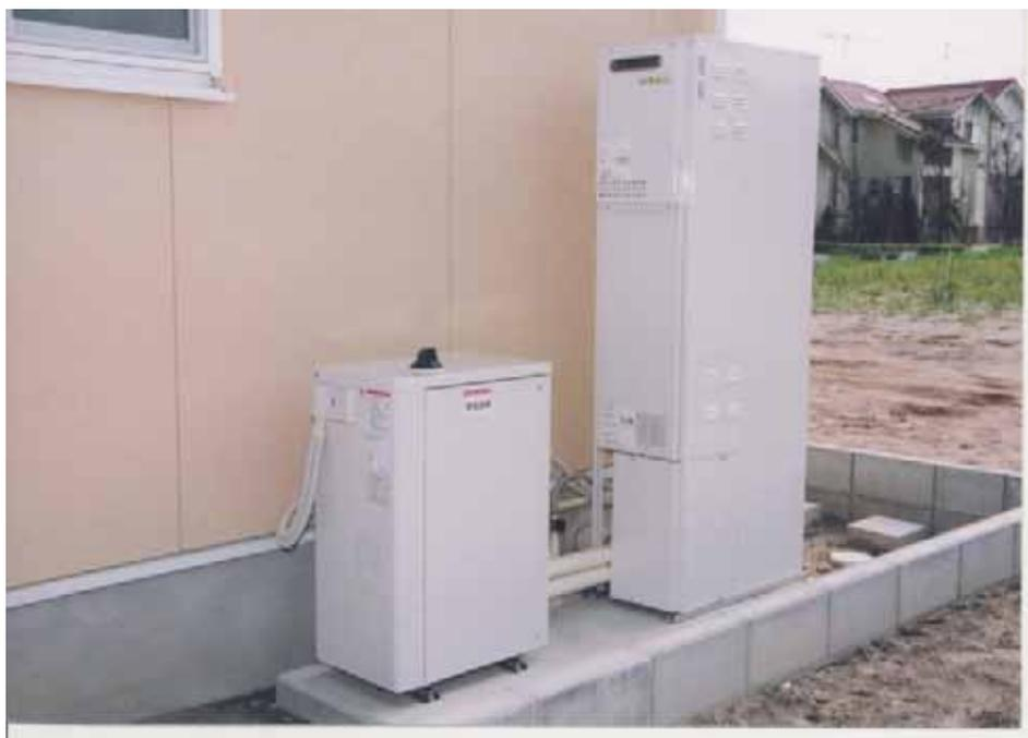
左：ガスエンジン発電ユニット、右：排熱利用給湯暖房ユニット
