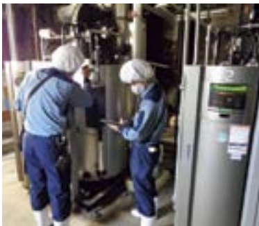
ボイラー調査作業
