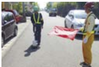
ガス検知器を使用しての漏えい検査
